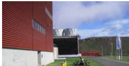
Foto: Der Eingang zum Besucherzentrum des Krafla- Kraftwerks im Hintergrund die Kühltürme
